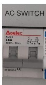
Position Basse : Source connectée sur la sortie Réseau (AC GRID)
